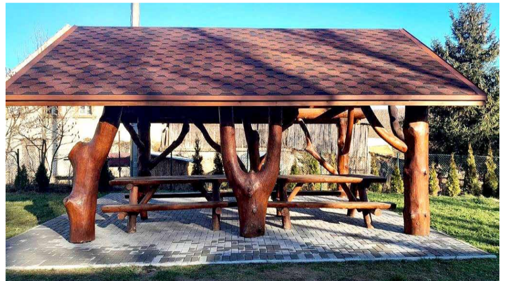
Zakup kostki do utwardzenia powierzchni wewnątrz wiaty biesiadnej w Laskach
