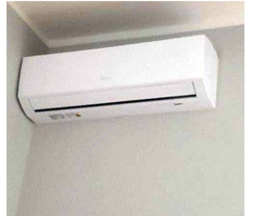
Montaż klimatyzatora w świetlicy w Mąkolnie
